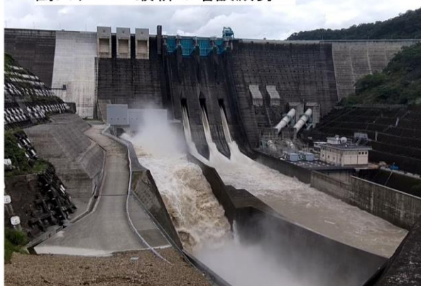
鶴田ダム：最新の増設減勢工
