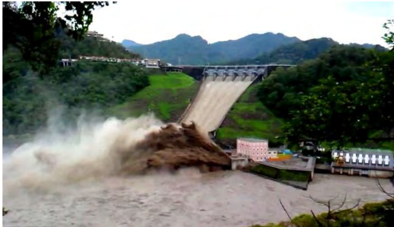
参考-5 石門ダム底部放流設備（運用中）からの土砂排出状況 3)
