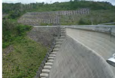
大保ダム: 2010年 完成、堤高77.5m
