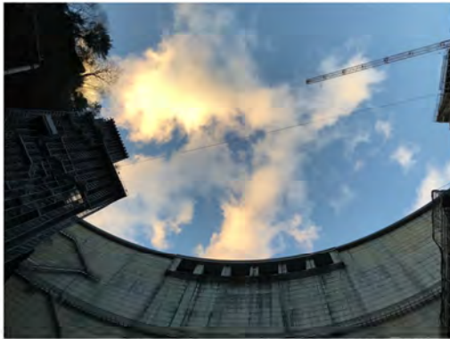
川俣ダム：50年前に国内最初の大規模アンカーである岩盤PS工を実施。2018年から更新工事を実施。写真左手に工事用足場が見える。
