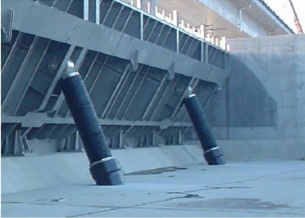
写真 1-3 鋼製起伏堰（油圧押し式）の例
