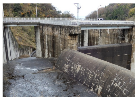
写真-3 洪水吐きコンクリート状況
