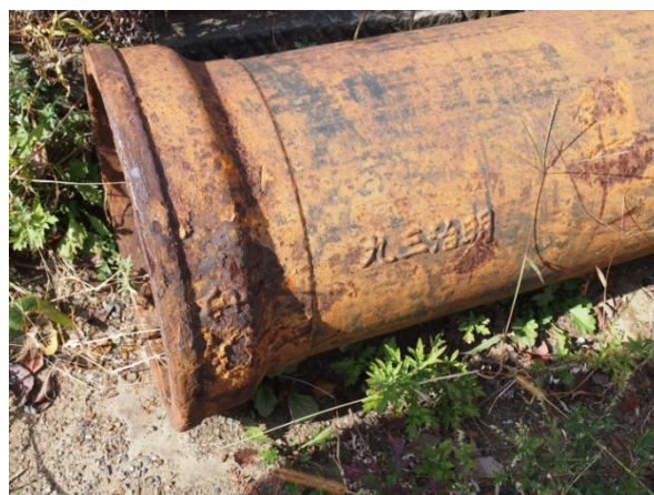
写真-1 明治39年製造の鑄鉄管 （敷地内の置いてあったもの）
