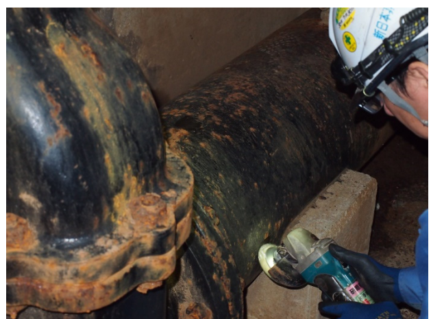
写真-6 グラインダー研磨（測定面平滑化）
