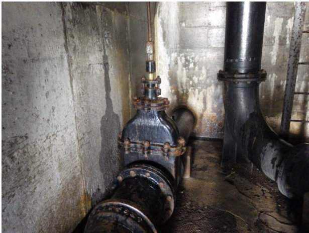
写真-2 測定対象（排泥管、取水管）
