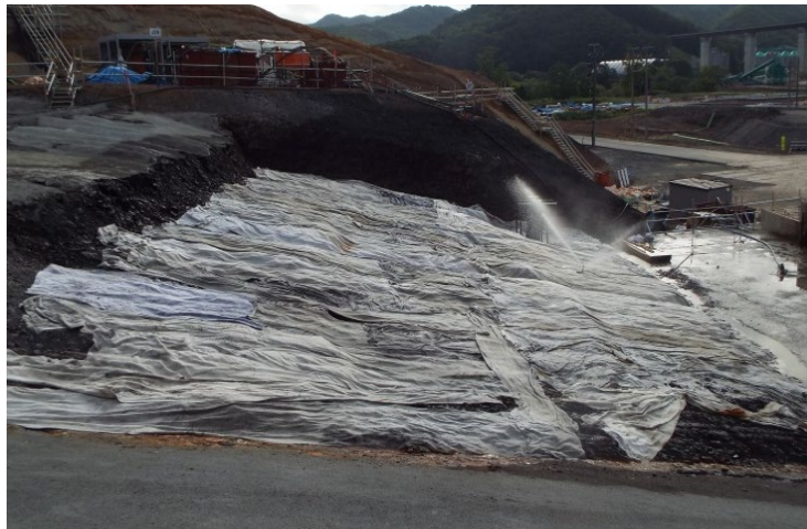
Fig. 15 Moisture mat curing of dam foundation Maturation par l'humidité de la fondation du barrage
