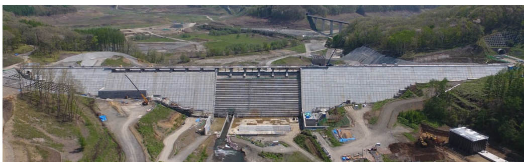
Fig. 1 Apporo dam under construction Barrage d'Apporo en construction
