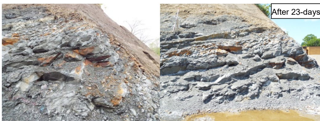
Fig. 4 Slaking of shale strata exposed at long period Relâchement de la couche de schiste exposée à longue période
