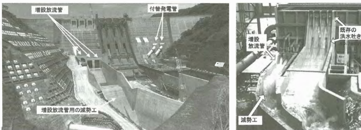
図-1 鶴田ダムの改造状況（2017年6月）（左）と水理模型（右）
