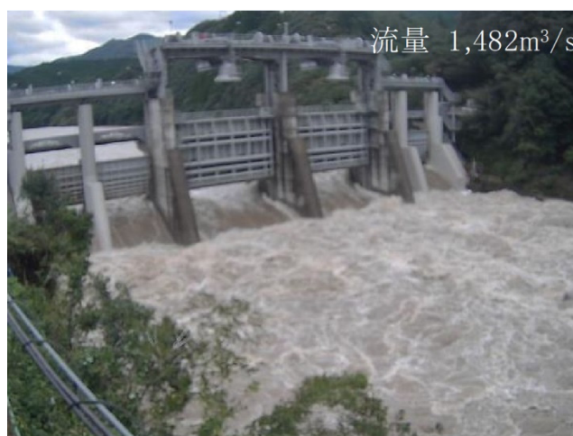
写真-1 Aダムの通砂状況
