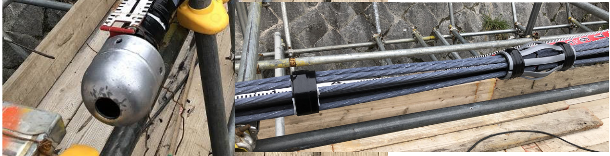
写真-4 千本ダムにおける布パッカー施工
