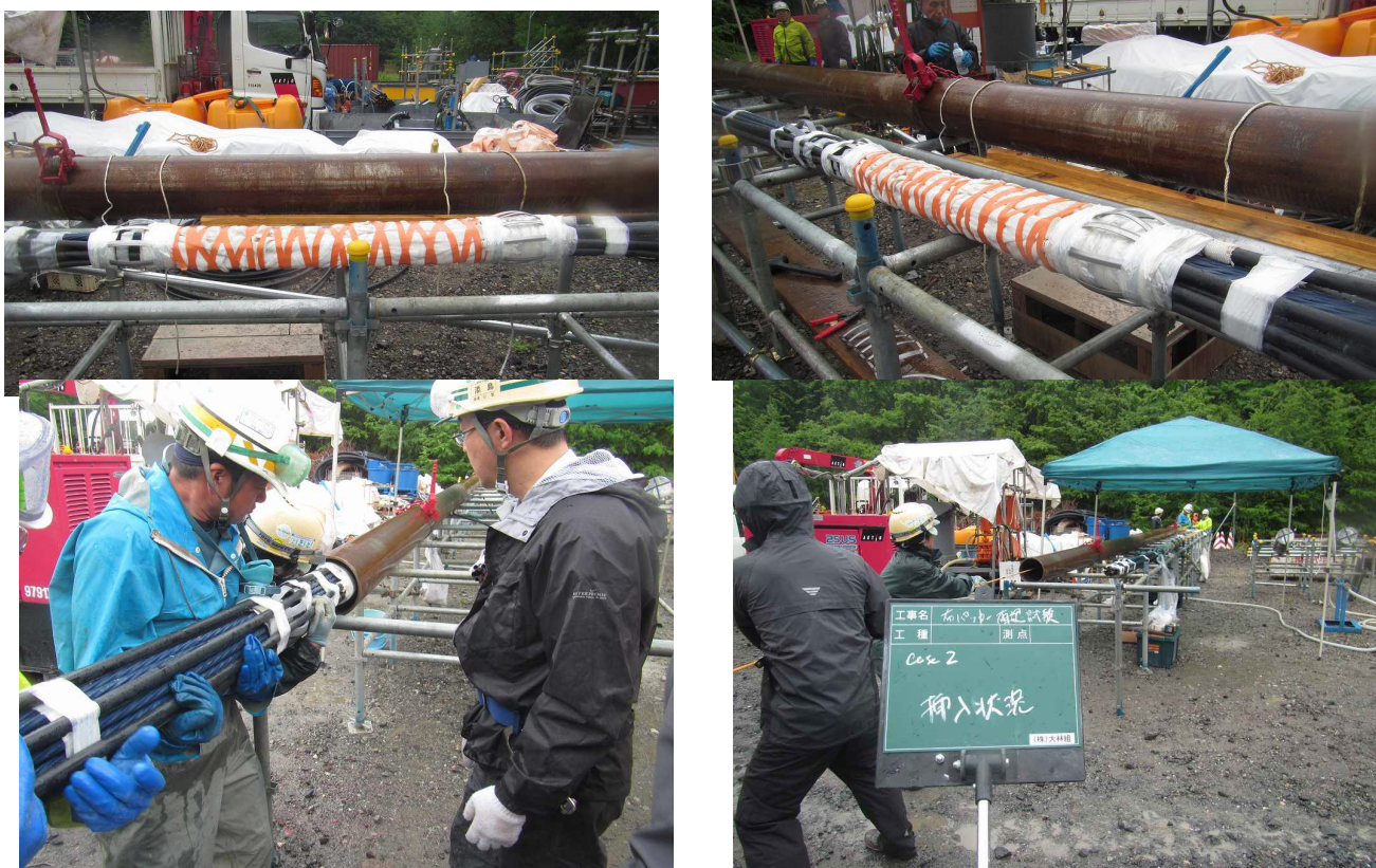
写真-1 Case7 挿入試験時状況：5往復（80m相当）の移動に対して引っ掛かり等は無かった。
