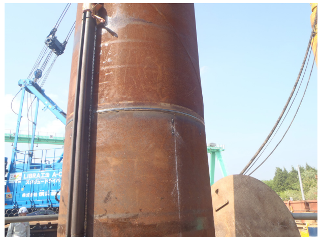
写真-4.2 ジョイント部
