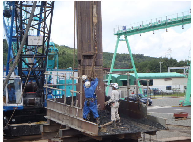
写真-4.1 試験施工の様子
