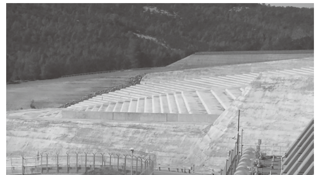
写真-3.5 非常用洪水吐き RCC 打設状況（階段状）
