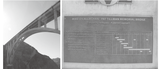
写真-4.1 コロドリバーブリッジ (左: 全景, 右: 橋上高欄部設置の工程表)
