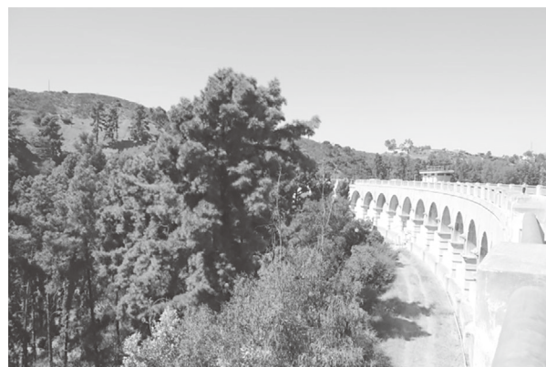
写真-6.1 マルホランドダム全景（左岸側より望む）
