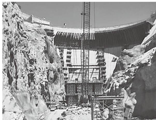
写真-7.2 増厚コンクリート打設
