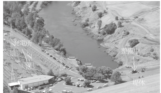
写真-3.4 ダム堤体下流左岸側整備状況
