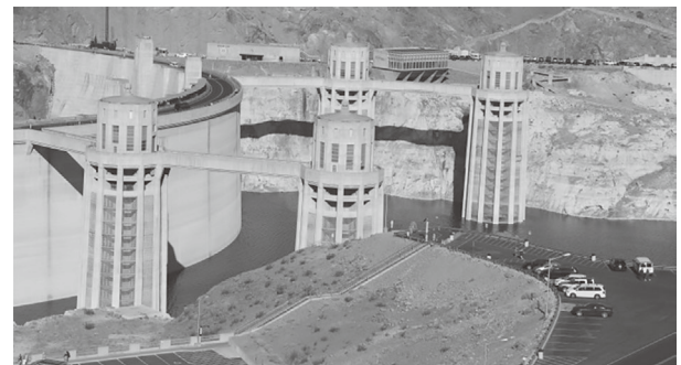
写真-4.2 フーバーダム上流側全景
