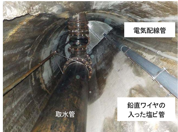
写真-3 取水塔内の鉛直ワイヤの設置状況
