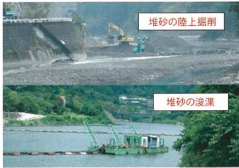
写真-6 汎用機械による堆砂の掘削と浚渫 5)
