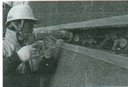
写真-1 充填工法によるアーチ式コンクリートダム打継面部の漏水対策 6)
