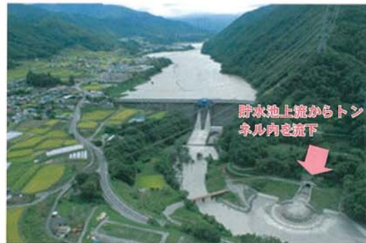
写真-4 土砂バイパス(洪水の一部を貯水池上流端付近からダム下流にバイパス) 5)
