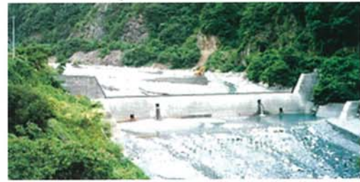
写真-7 貯砂ダム（土砂を捕捉し掘削） 5)
