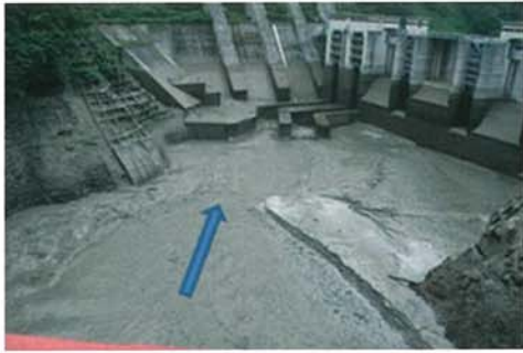
写真-5 土砂フラッシング・スルーシング（貯水位を低下させて土砂を放流） 5)
