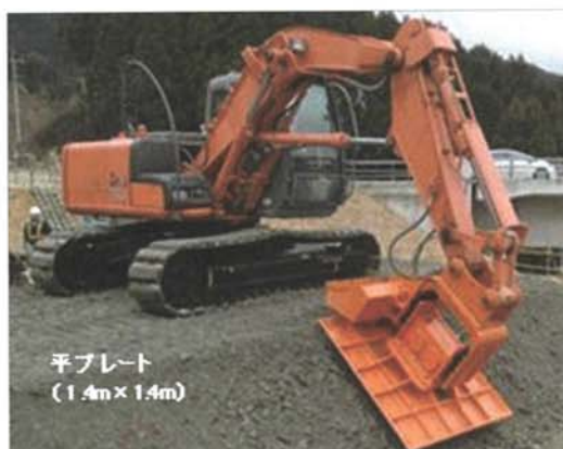
写真-2 FPC (Flat Plate Compactor) による端部法面締め 6)
