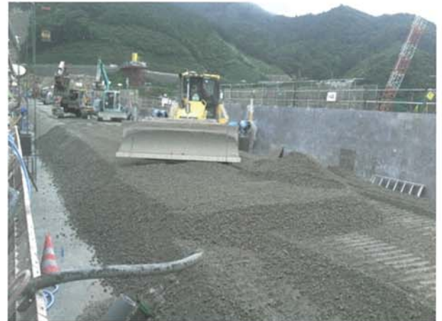
写真-4 高標高部におけるRCD工法の施工状況 6)
