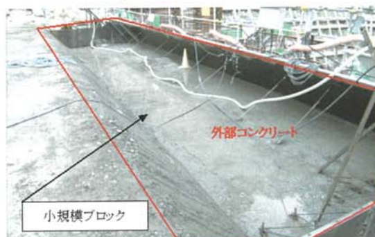
写真-3 外部コンクリートの打設ブロック 6)
