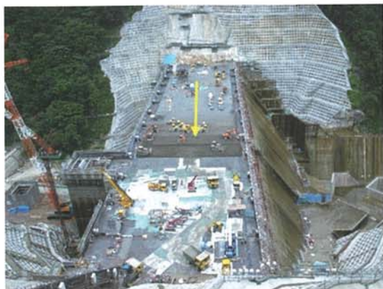
写真-1 基本施工法の一つであるRCDコンクリートの先行打設状況 6)
