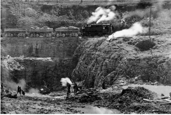
図-8 掘込み式跳水式減勢工の岩盤掘削状況
