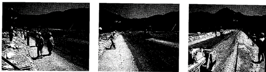
図-4 緑川ダム脇ダムのコア修復方法 6)
