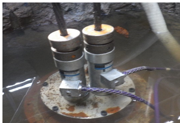
図-1 千本ダム PS アンカー（孔径 165mm）における 2 深度の軸力計測ストランドの設置状況
