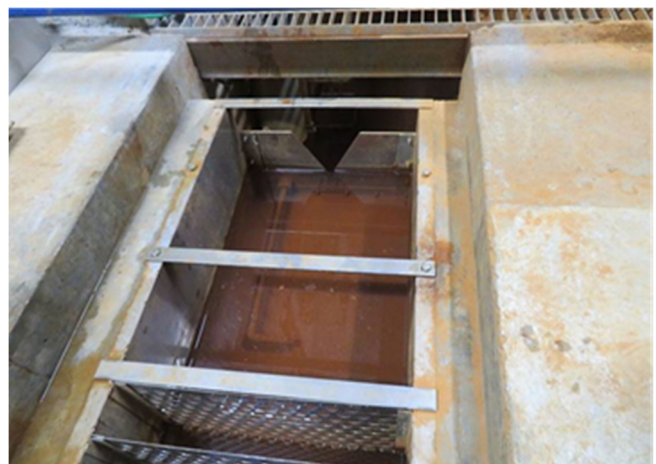
写真-2 清掃後の状況
