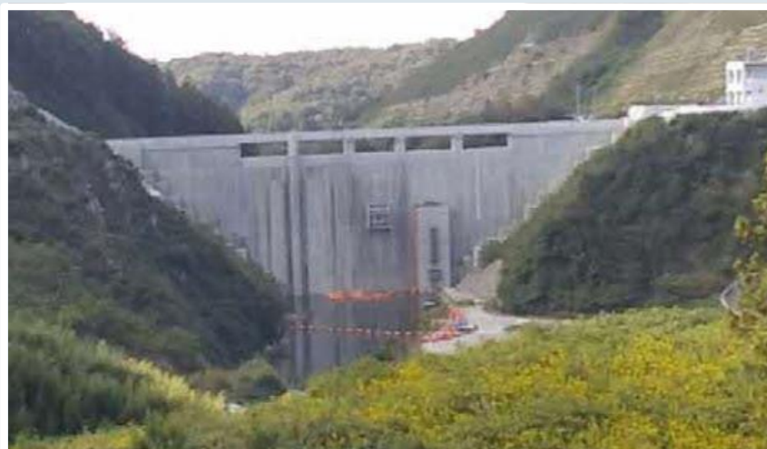
▲R5.10.17 貯水位 EL55.78m（試験湛水14日目）
