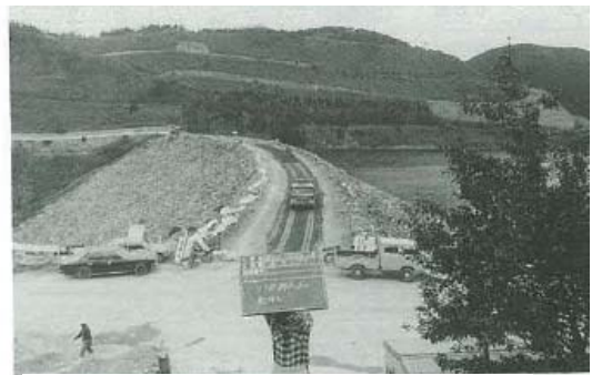
コア材の搬入敷均し 1)
