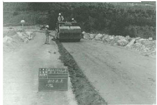
コア材の転圧 1)
