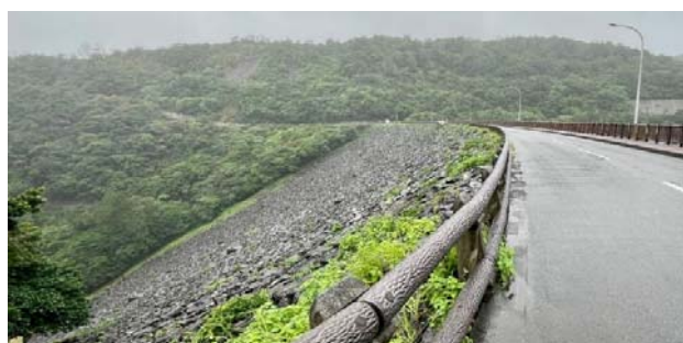
図 9 福地ダム堤体（下流側）
