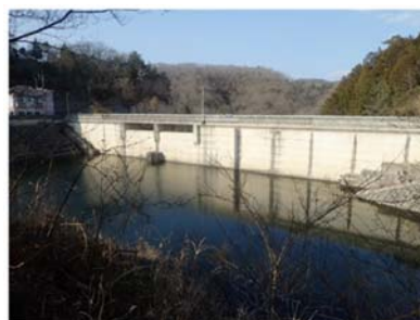
写真-2 長谷ダム上流面
