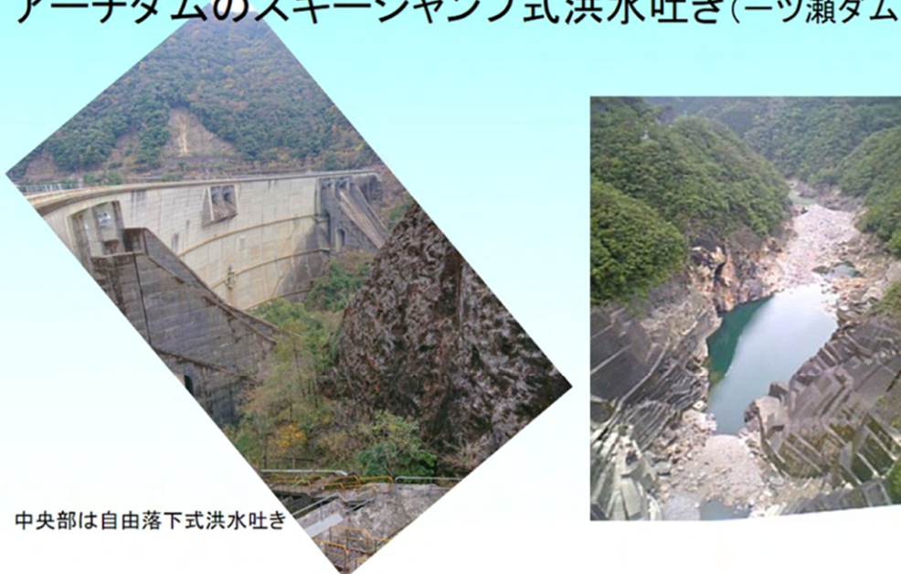
図17 アーチダムのスキージャンプ式洪水吐き(一ツ瀬ダム:1961)
