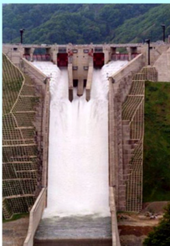
図16 導流部での階段式減勢(寒河江ダム:1990)
