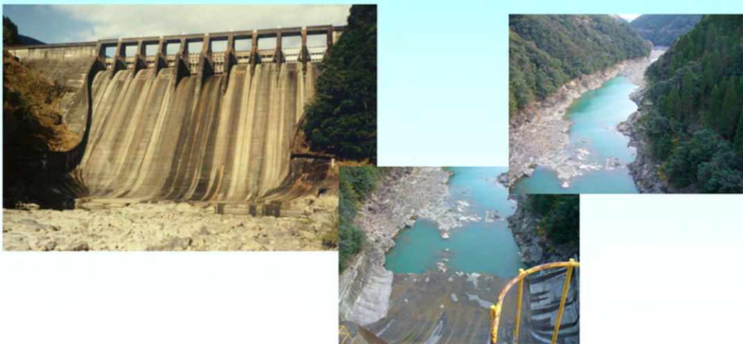
図10 副ダムのない減勢(松尾ダム:1951)
