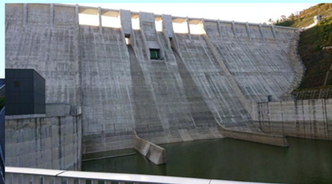
図14 分離壁を設けた減勢工(津軽ダム:2016)
