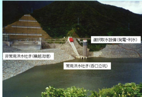
図15 各種放流設備に応じた減勢工(三国川ダム:1993)
