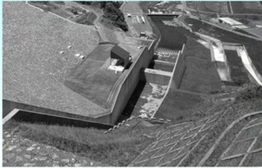
図15 各種放流設備に応じた減勢工(三国川ダム:1993)
