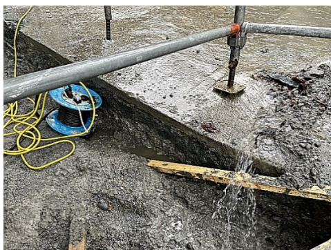
図9 増厚50cm部のSFRCの打設1年後の状況 (手前は当年度打設面) 2021年12月
