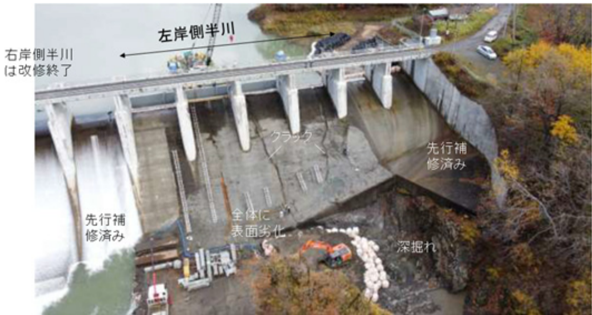
図6 左岸側の半川締切りによる改修直前の状況（右岸側は前年に改修終了） R3年10月28日撮影
