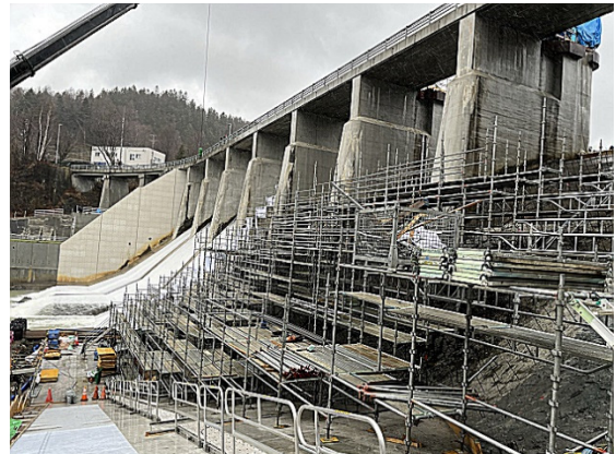
工事用足場兼雪囲いの設置状況
