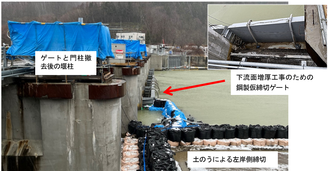
図7 左岸側仮締切設置後の堤体上流側の状況 2021年12月2日撮影
