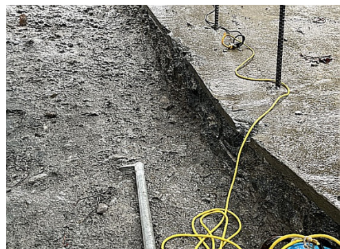
図9 増厚50cm部のSFRCの打設1年後の状況 (手前は当年度打設面) 2021年12月
