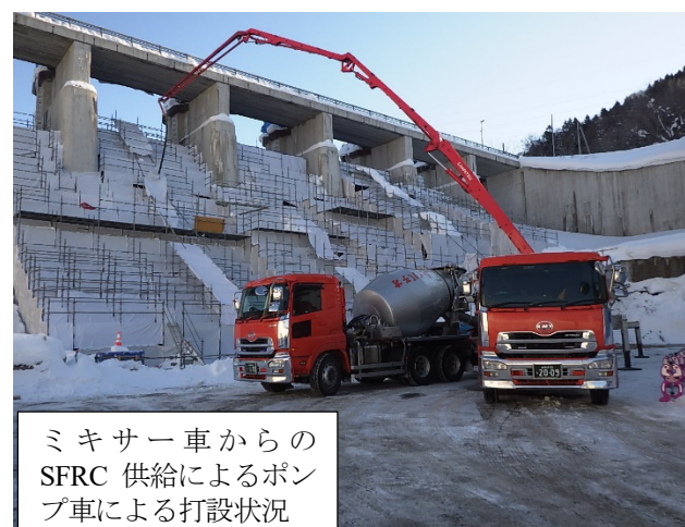
図 11 2021 年度冬の左岸側施工状況 表面研り後の打設面
