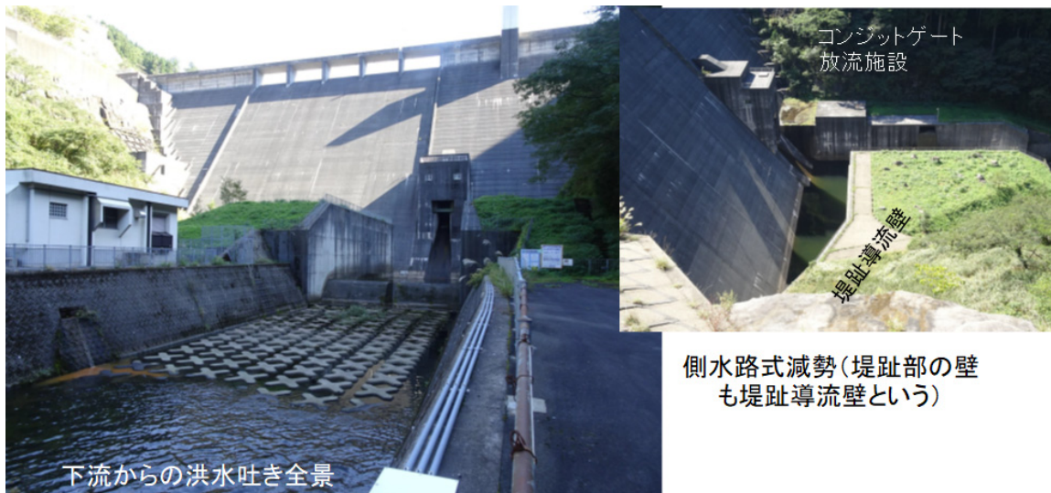
図8 側水路減勢機能付きの堤趾導流壁の先駆け（福井県・龍ヶ鼻ダムの事例）
