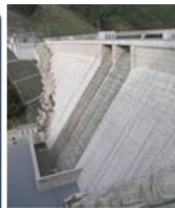
下流面に導流壁のない形状 写真：山口県
