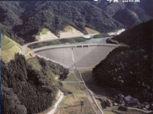
図 6 湯免ダムの下流面の状況
