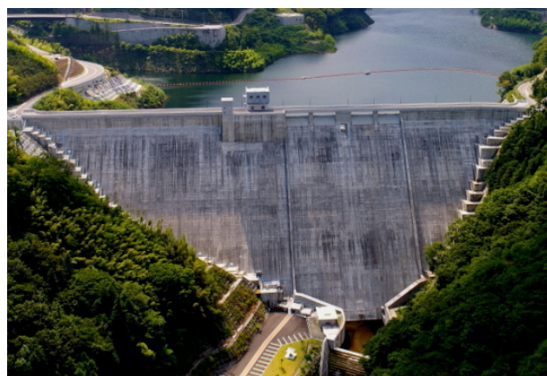
②栂川ダム（香川県）2023年完成、堤高88.5m
