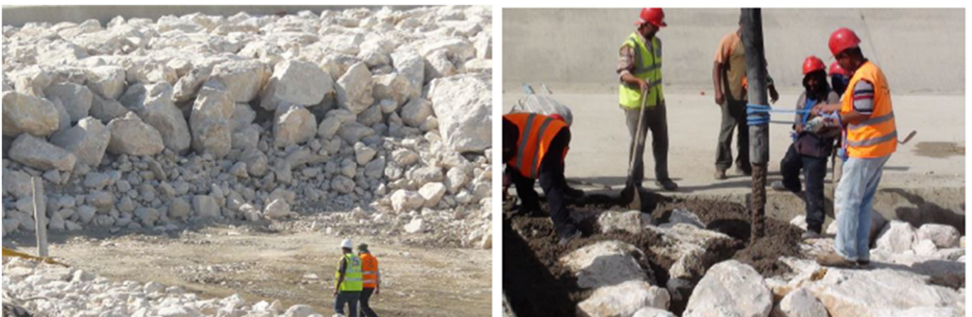
図 9.9 Cemented 巨石の施工状況
