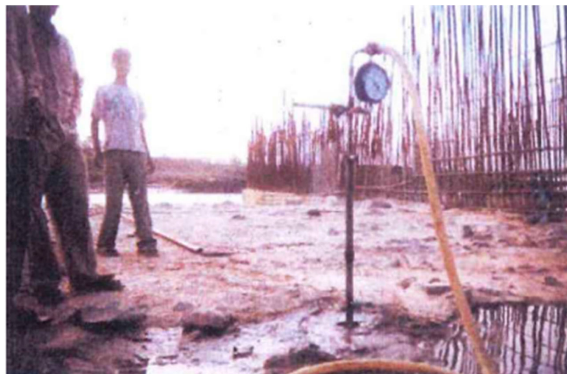
図 9.6 Colgrout 石積打設面における原位置透水試験
