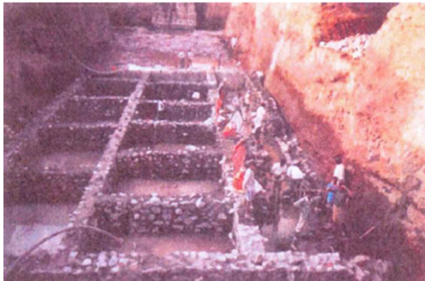
図 9.4 Colgrout 石積打設前の隔壁の状況
