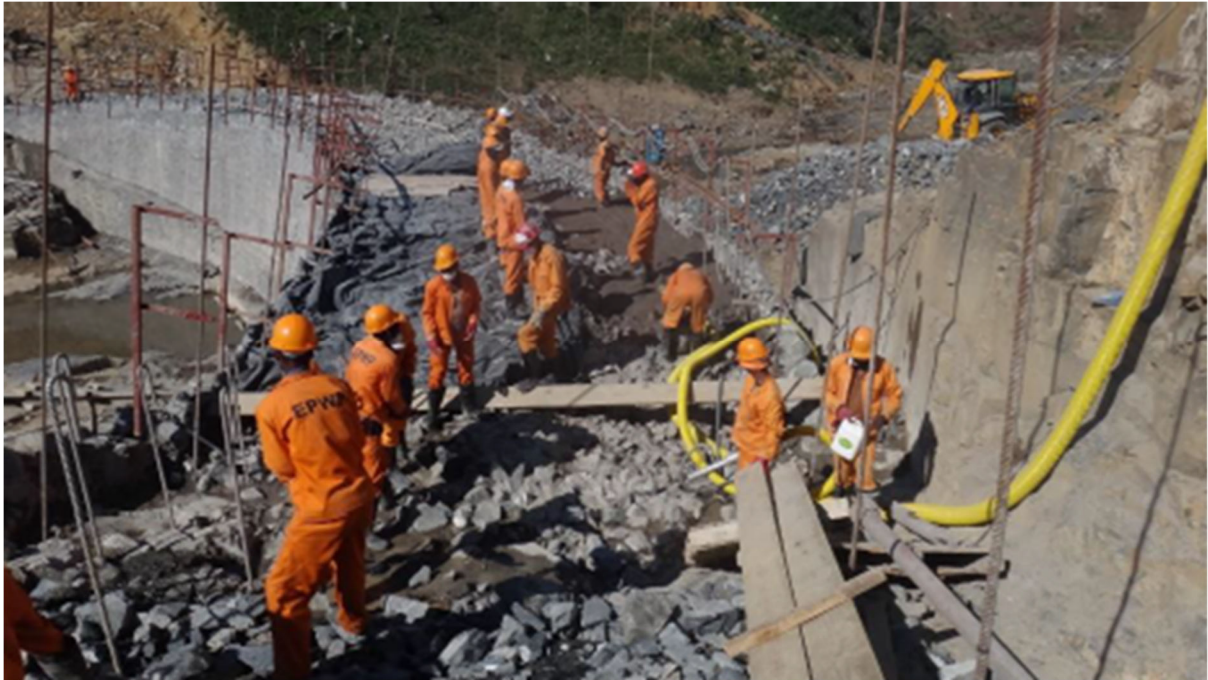
図 9.2 RMC の打設状況
