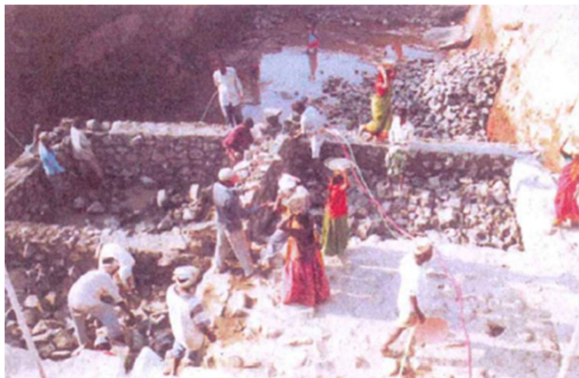
図 9.5 Colgrout ロックフィルあるいは岩石配置前の状況
