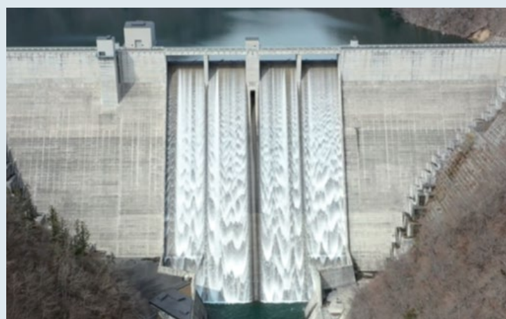
▲非常用洪水吐より越流している湯西川ダム (令和2年4月点検放流)
