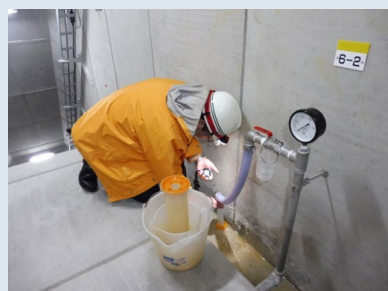
▲基礎排水孔からの漏水量の測 定及び揚圧力を行っている
