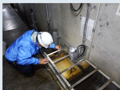
▲三角堰(5カ所)の水量を毎日計 測している
