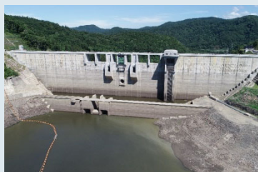
▲ダム湖側から見た“津軽ダム”と“目屋ダム”の位置関係 (令和元年8月15日撮影)
