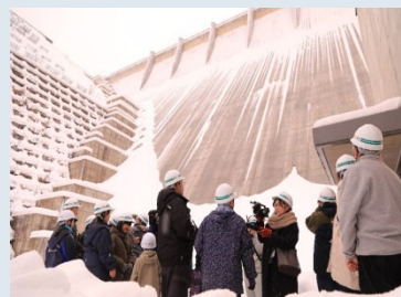
▲放流バルブ室前から雪の津軽ダム を見上げます。
