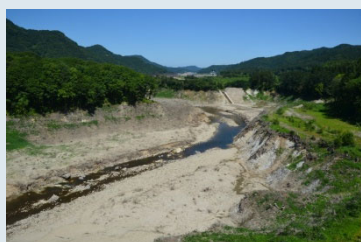
▲渇水により川のように見えるダム湖貯水池上流部の様子
