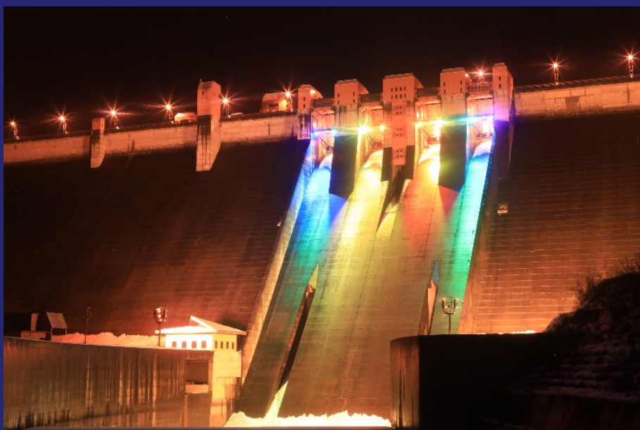
浅瀬石川ダム“ライトアップ”の様子
