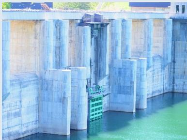
▲コンジット予備ゲートを全閉してダム湖からの水を遮断します。
