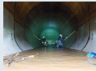
▲放水直後は流木などが残っています。清掃し、その後放流管内部に異常がないか確認します。
