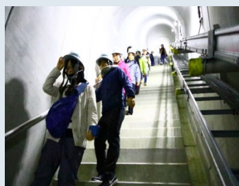
▲ダム堤体内部の“急な階段”です。 皆さん、慎重です！
