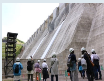
▲ダム見学終盤、ダムを見上げて大 きさを実感していただきます！
