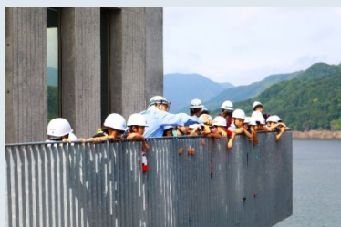
▲ダムの上から“ゲート”について説明をうけています！
