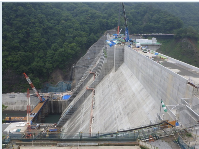
▲ハッ場ダム本体（左岸から、R元年6月撮影）
