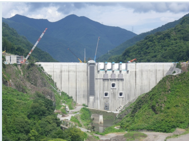
▲ハッ場ダム本体（上流から、R元年8月撮影）
