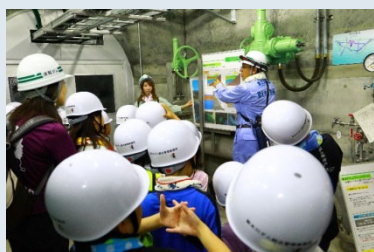
▲ダム堤体内部で“水の濁り対策”について勉強しました！
