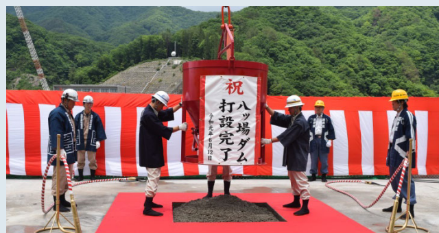
▲コンクリート最終打設
