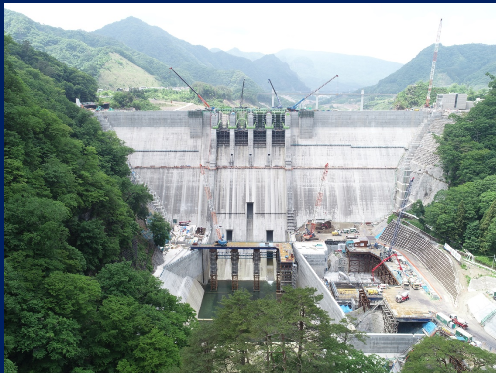
ハッ場ダム本体(下流から、R元年6月撮影)
