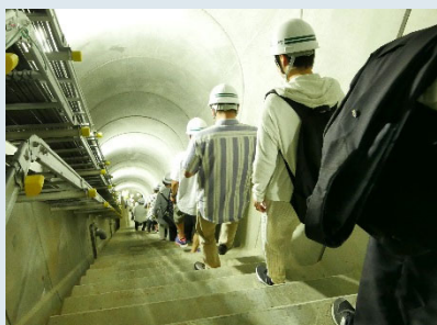
▲監査廊も歩いていただけます
