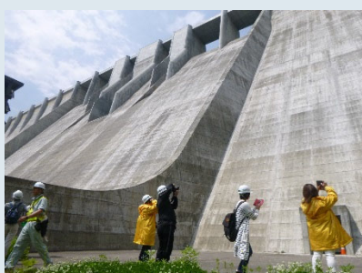
▲ダムを見上げ驚きの様子！
