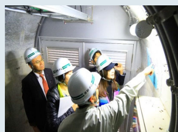
▲ダム堤体内部も取材しました。 興味津々です！
