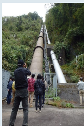
▲中島発電所にて巨大な水圧鉄管を見学
