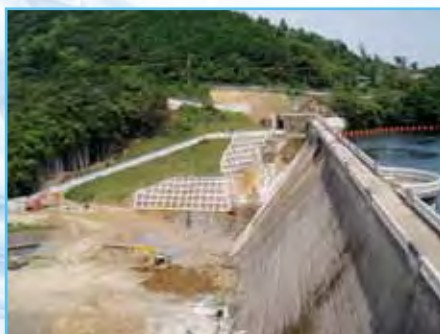
嵩上げ工事前(下の原ダム)
