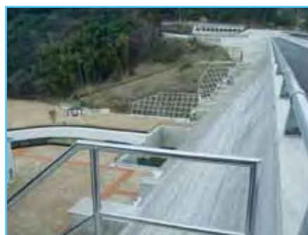
嵩上げ工事後(下の原ダム)
