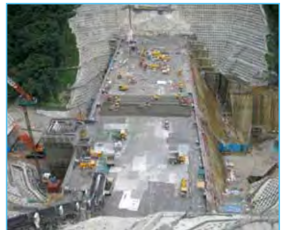
湯西川ダムでの施工状況
