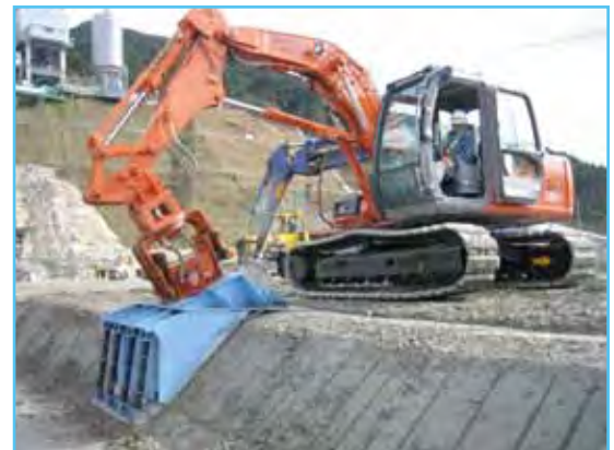
RCDコンクリートの先行打設状況写真 (嘉瀬川ダム)
