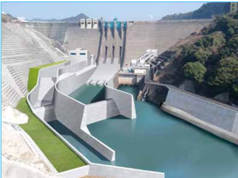
堤体に孔を開け放流設備を増強する鶴田ダムの再開発時の完成予想図
