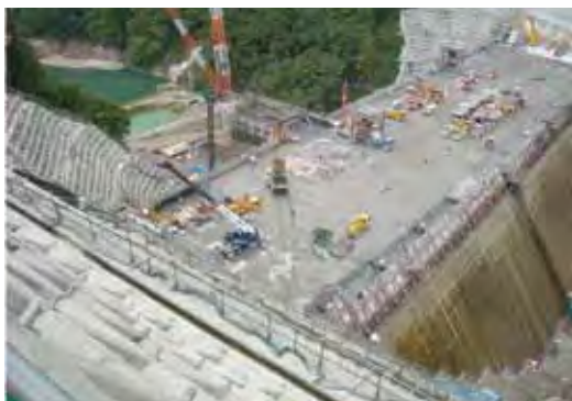
巡航RCD工法 湯西川ダム
