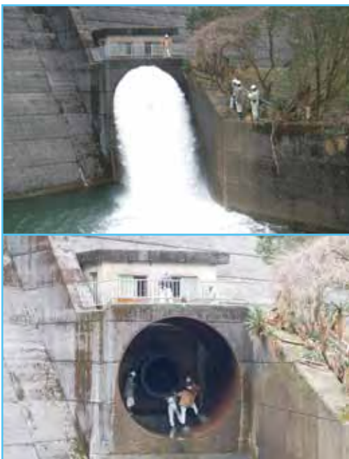
試験放流による放流設備の機能確認 （ハウエルバンガーバルブ）
