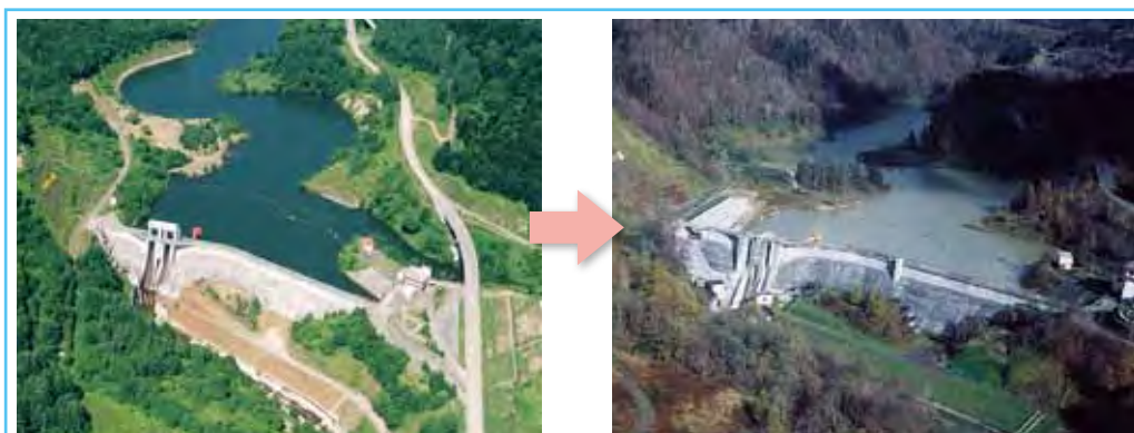
ゲートを撤去し自然調節方式に改造した美唄ダム(美唄ダムの改造前、改造後の写真)
