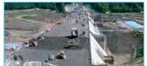
当別ダム施工状況
