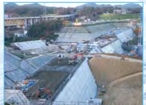
億首ダム施工状況
