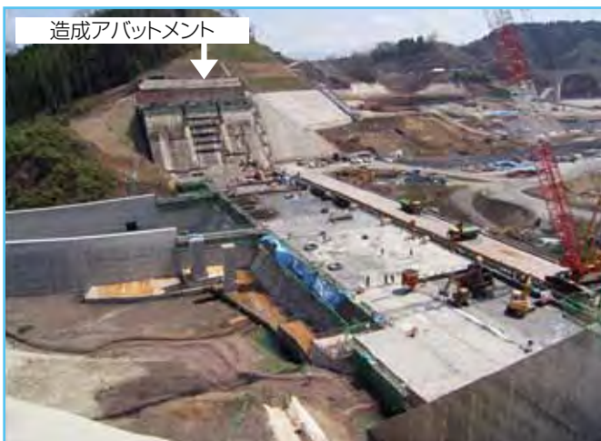
稲葉ダム、傾斜型造成アバットメント
