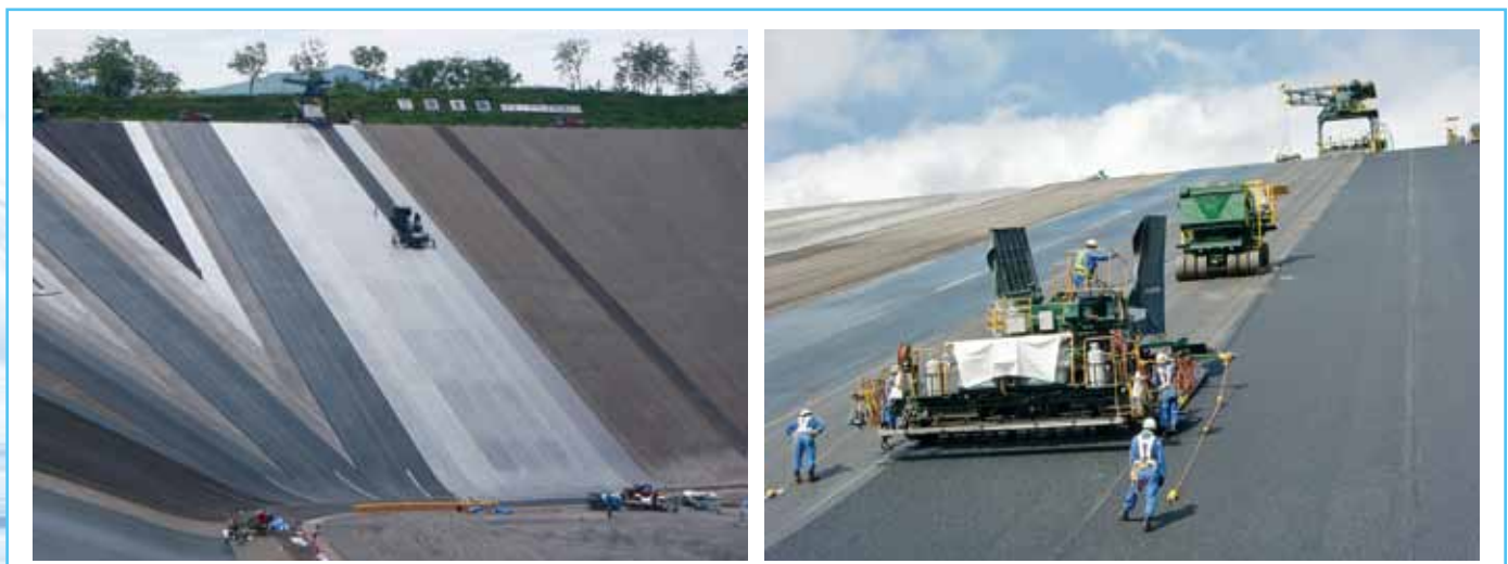
アスファルト表面遮水壁型フィルダム (AFRD) の施工状況 (京極発電所上部調整池)
