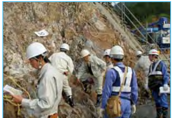
評価・助言状況 仕上げ掘削確認状況
